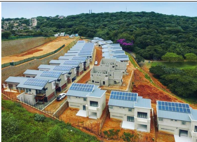
图表 31 固德威南非 120kW 光伏储能项目
