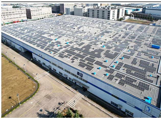
图 35：达能中国饮料 4.3MW 光伏项目（分布式）
