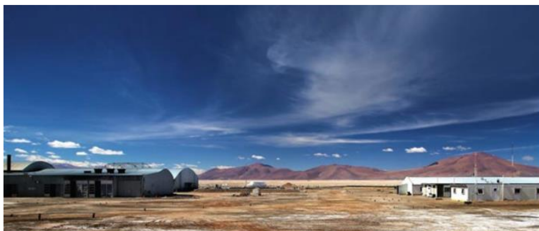
图38：Rincon 盐湖建设现场
