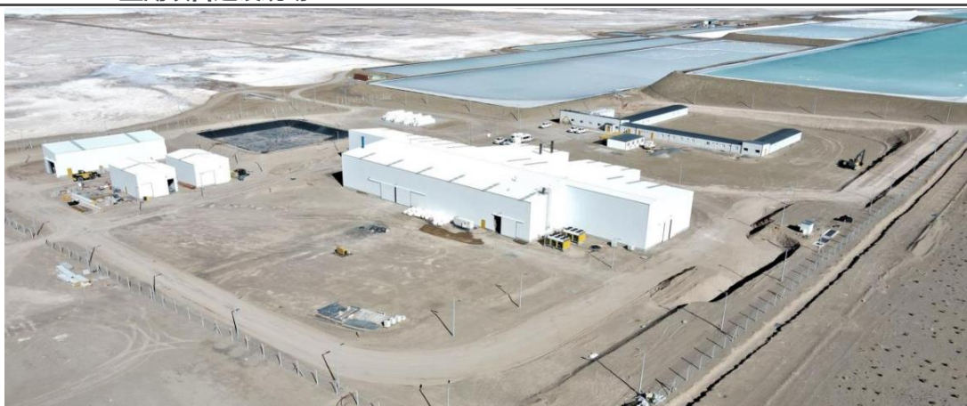
图35：Rincon 盐湖项目建设现场
