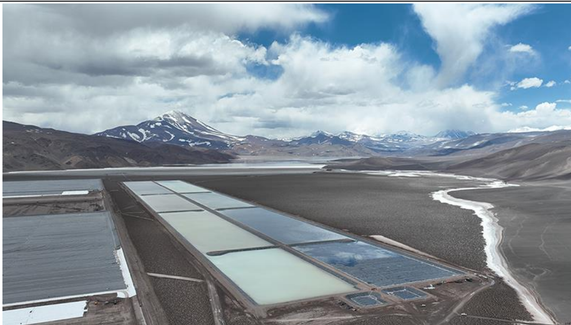
图34：3Q 盐湖小预浓缩池建设完工，注入卤水开启正式晒卤
